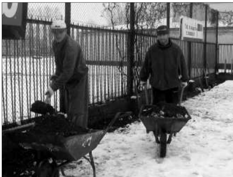
W budowie kortu Grzegorzowi Jasińskiemu (od lewej) pomagają jeden z osadzonych z Zakładu Karnego w Garbalinie
